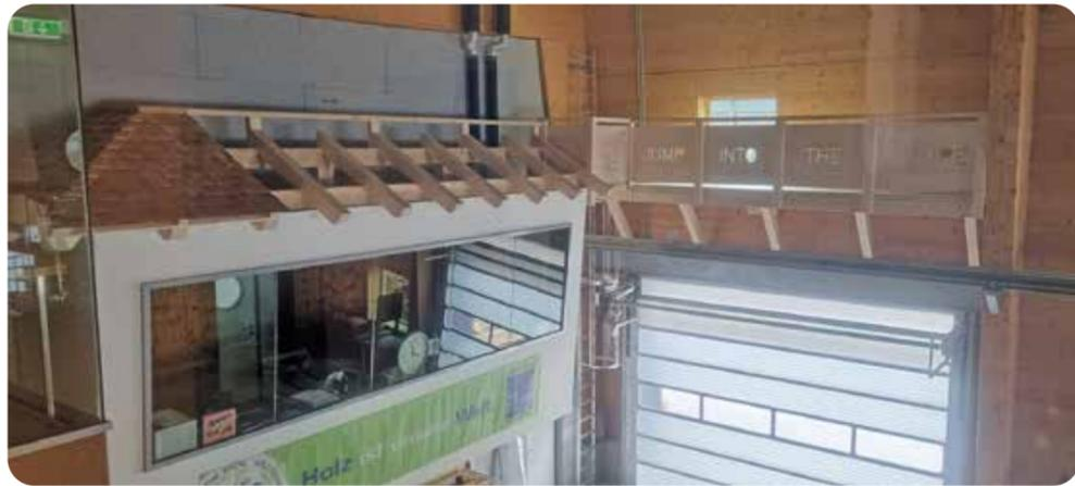
ten erstellt, sodass der Materialaufwand berechnet und das Material bestellt werden konnte. Der Fertigungsprozess wurde mit dem Dachstuhl begonnen, und zwar: Abbund der Einzelteile (Pfetten, Säulen, Sparren, Gradsparren und Schifter).
